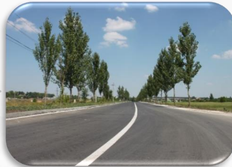
Conectarea Zonei Economice Libere „Bălți” la utilitățile municipale: apă, canalizare, electricitate, drumuri de acces
