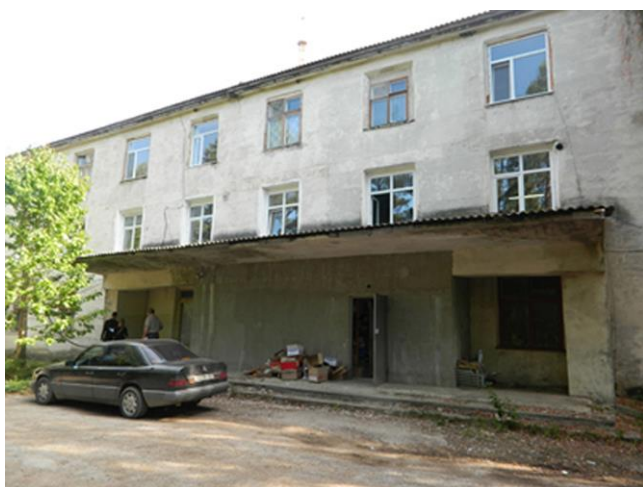
Figura 6-3: Clădirea 1, fațada de nord
