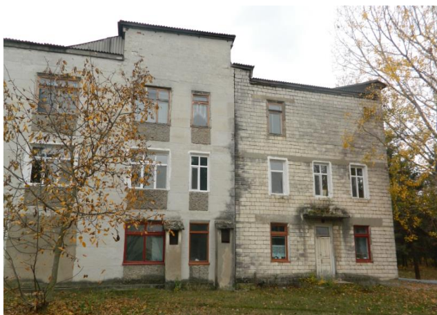
Figura 6-4: Clădirea 1, fațada de est
