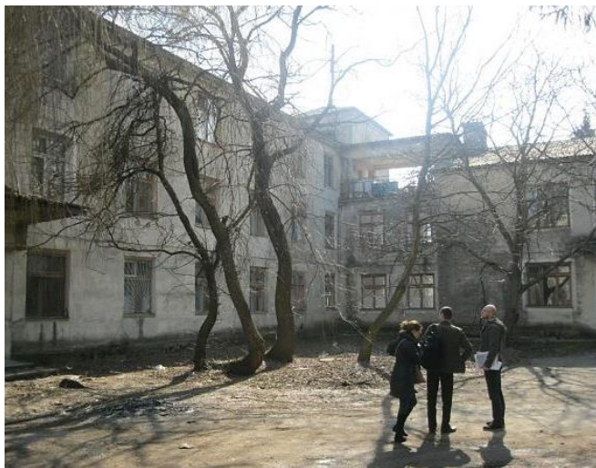
Figura 6-7: Clădirea 1, colțul de nord-vest, coridorul de conexiune cu terasa acoperită
