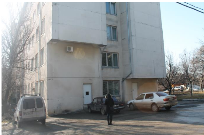
Figura 6-6: Vedere din partea de nord
