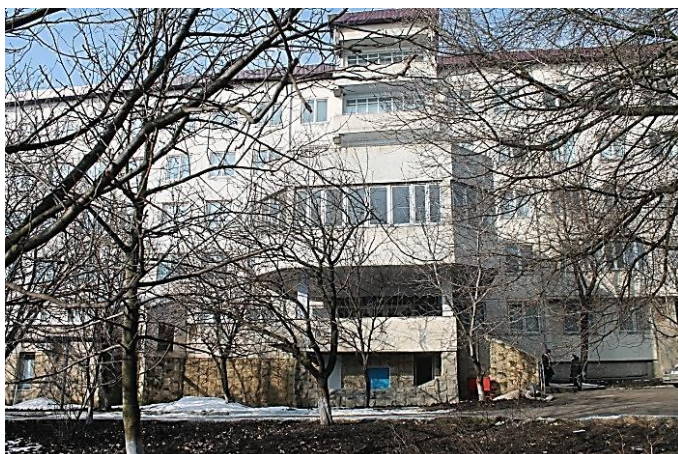
Figura 6-2: Clădirea A; intrarea principală, vedere din partea de est
