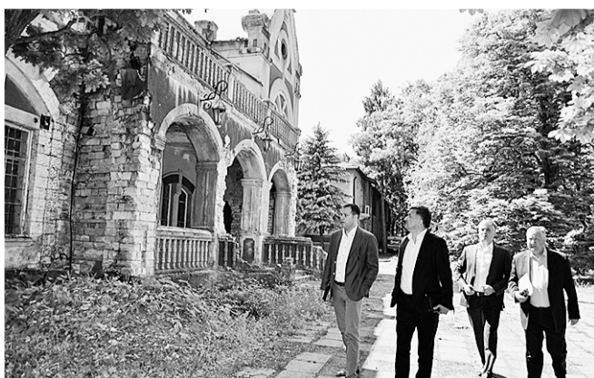
„Reabilitarea monumentului istorico-arhitectural Conacul Pommer și a drumului de acces la parcul dendrologic din satul Țaul, raionul Dondușeni”
