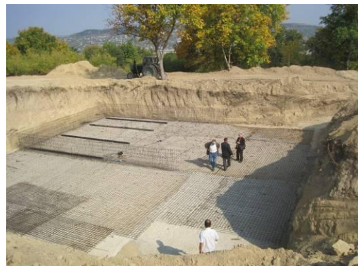
Lucrările de construcție a rezervoarelor de apă în derulare
