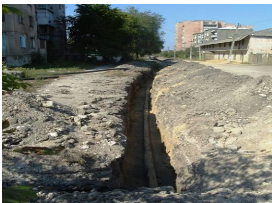
Lucrări de renovare a apeductului
